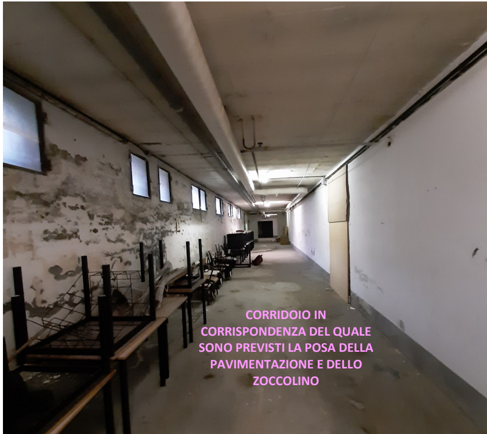
FOTO 1: Corridoio piano seminterrato
